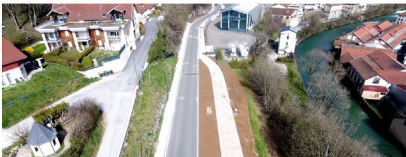
VILLE D'ORNANS (DOUBS) : « TRAVAUX D'EMBELLISSEMENT ET D'AMENAGEMENT DE L'ENTREE DE VILLE, ROUTE DE BESANCON » MENTION SPECIALE (COMMUNES DE MOINS DE 5000 HABITANTS) 2023
